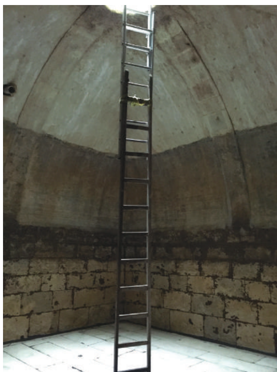
Figura 7. Cisterna do antigo Convento das Capuchas
