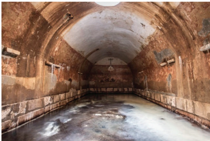
Figura 4. Cisterna do antigo Convento de S. Bento
