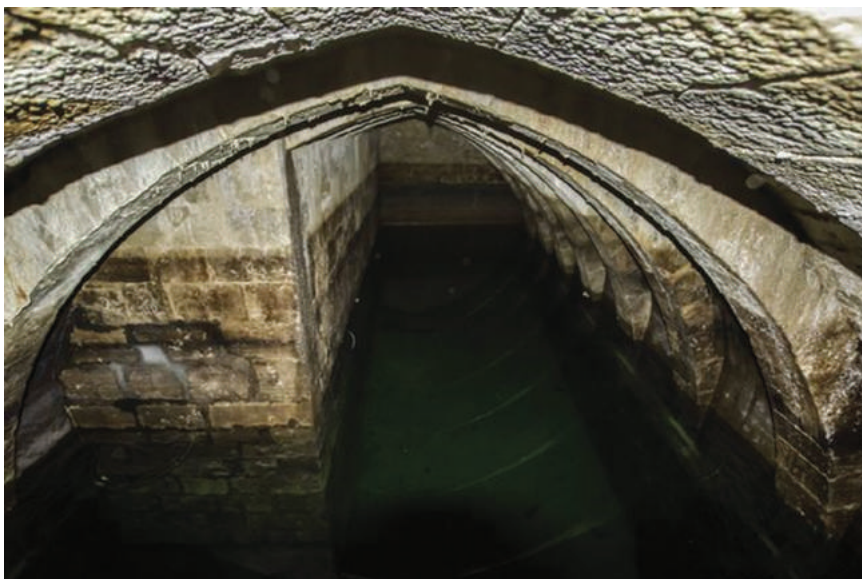
Figura 6. Cisterna do antigo Seminário de Santarém
