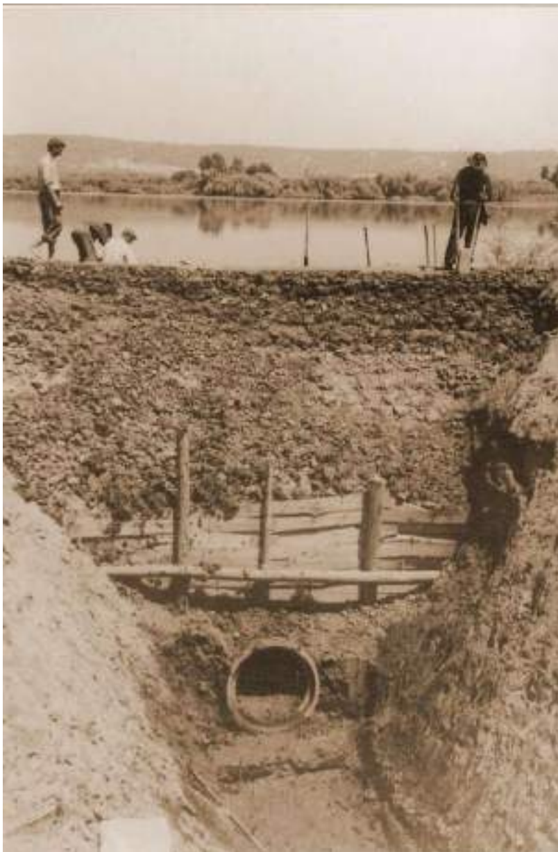
Figura 35 – Valadores, na construção de uma comporta na Lezíria Grande, anos 40 do Séc. XX. (Fonte: Tomaz, 2021)
