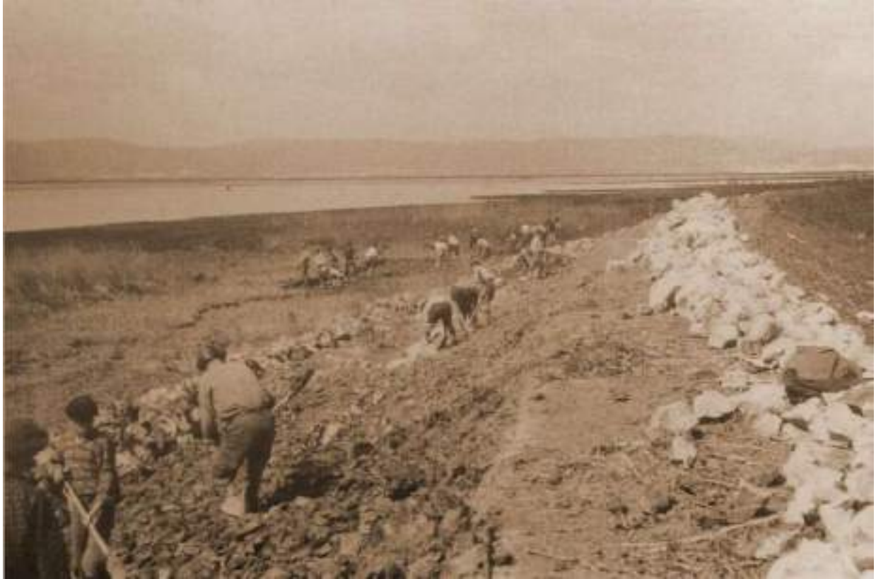
Figura 36 –Valadores na construção de um dique na Lezíria Grande, anos 40 do Séc. XX. (Fonte: Tomaz, 2021)
