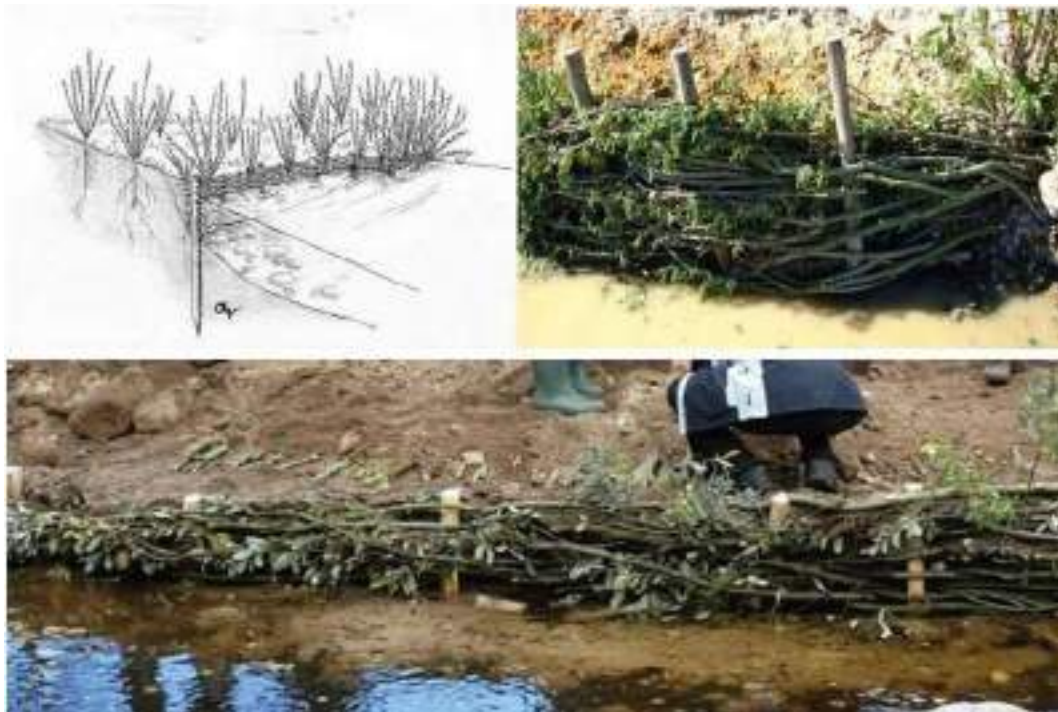
Figura 20 - Construção de entrançados vivos. (Fonte: Quinta-Nova, 2013)
