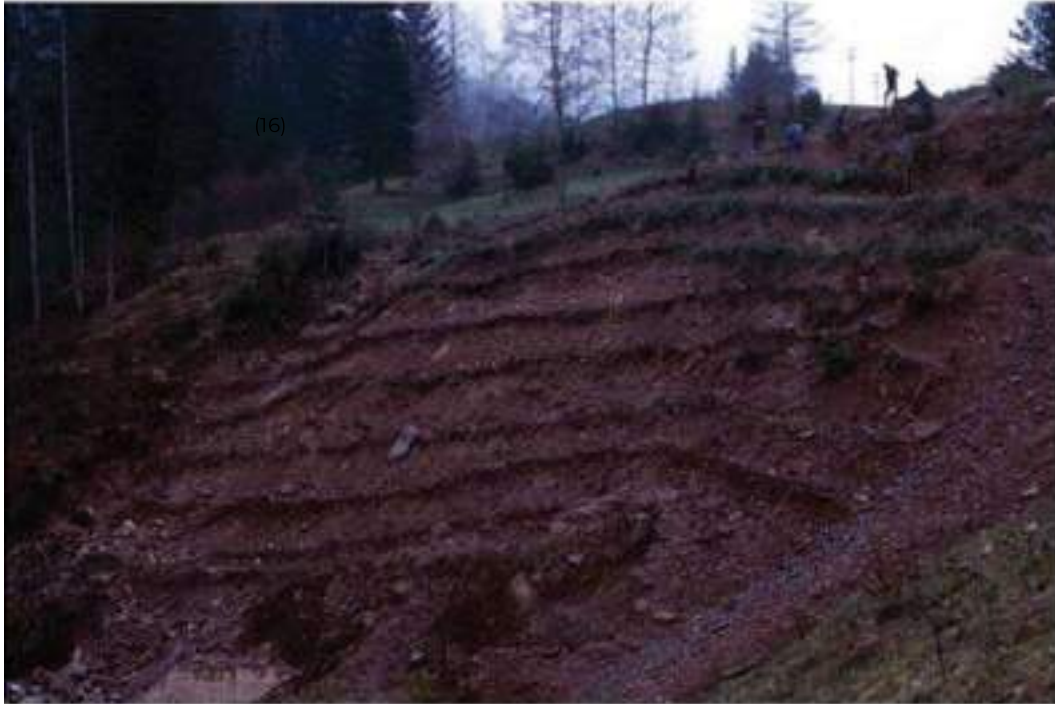
Figura 19 - Construção de leito de vegetação (Fonte: Fernandes & Freitas, 2011)
