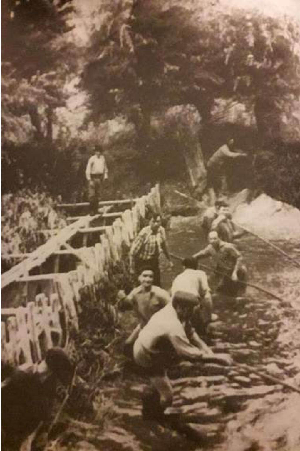
Figura 52 - Valadores riachenses construindo uma tapada (ou represa). O objectivo era elevar o nível da água para a comporta na Vala das Cordas. (Fonte: Simões, 2014)
