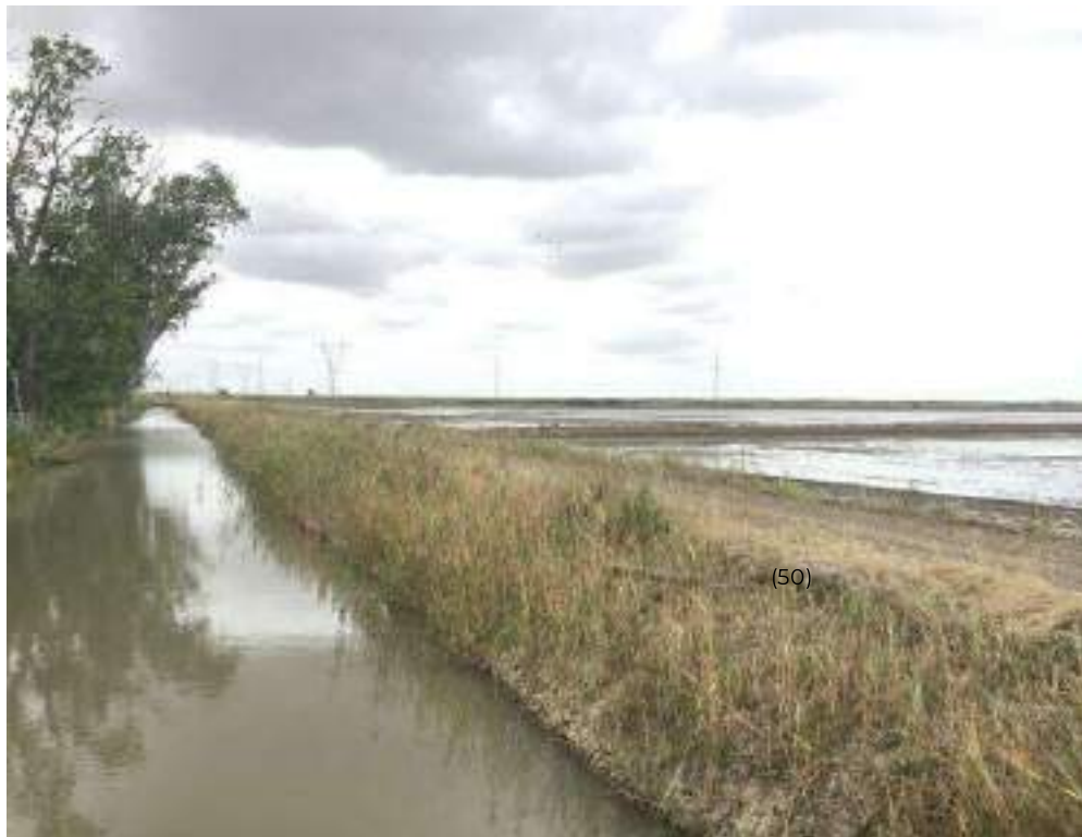
Figura 60 - Canal de rega na Lezíria Grande, na actualidade. (Fonte: Tomaz, 2021)
