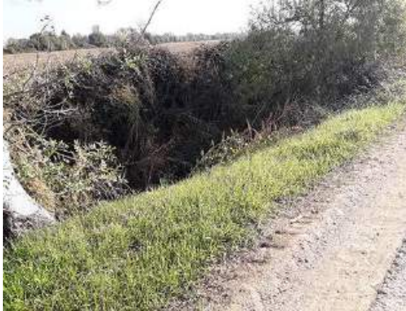
Figura 53 - Aspecto da Vale das Cordas na actualidade. O que foi construído pelos valadores ainda se mantém. Porém, a vegetação silvestre é de tal modo densa que deixa bem entender a falta que fazem, hoje em dia, estes valadores, que tão bem cuidavam destas linhas de água artificiais. (Fonte: foto do autor)
