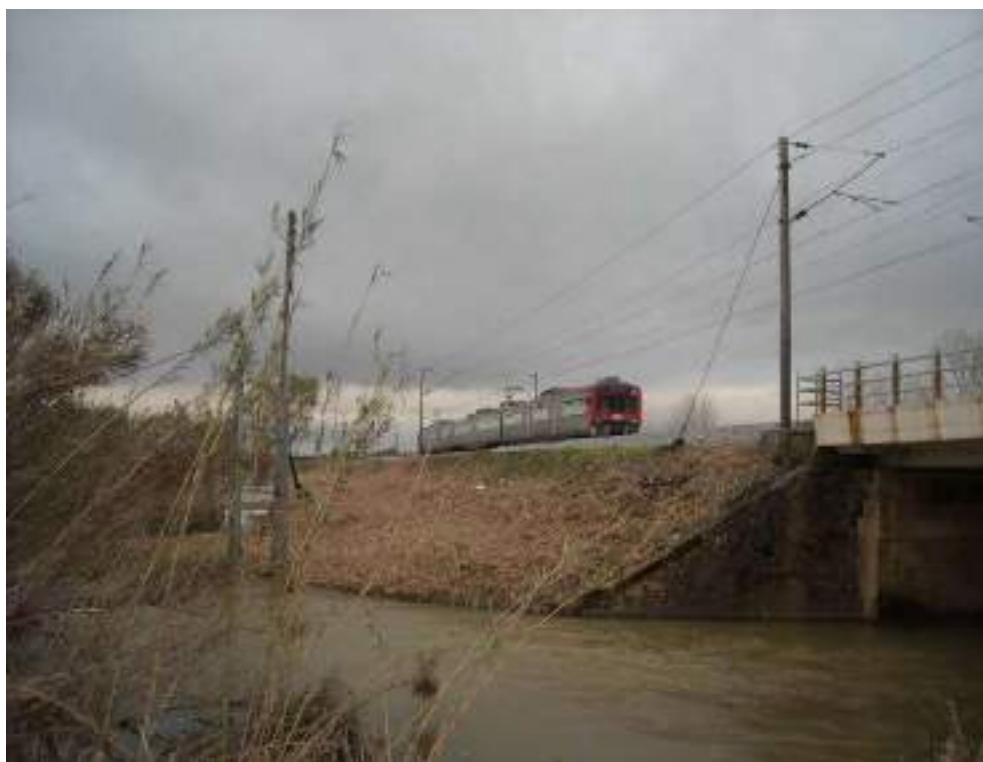
Figura 69 - A Linha do Norte, já no território da Freguesia de Riachos. Atravessa boa parte do território a que os riachenses dão o nome de "Campo". Instantâneo captado em tempo de cheia, junto ao Pontão referido na descrição desse território agrícola. (Fonte: foto do autor.)
