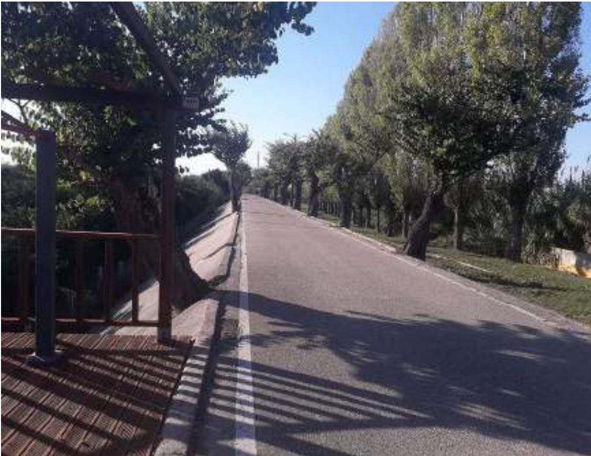
Figura 33 - O antigo Dique da Sr. a das Dores, na Chamusca, feito por valadores e cabouqueiros. Foi reabilitado como via pública, mas o plano de obras teve o cuidado de conservar as olaias da vertente, árvores centenárias existentes desde a feitura do dique. (Fonte: foto do autor)
