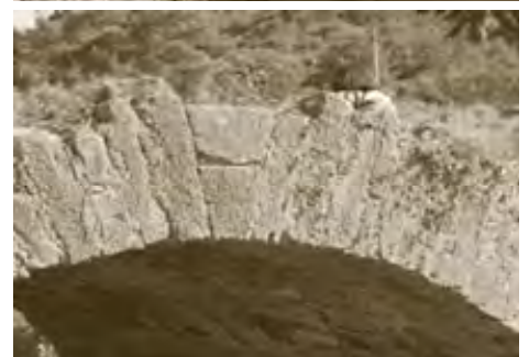
Imagens: Fotografia da área e estruturas
