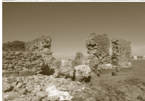
Imagens: Fotografia da área e estruturas
