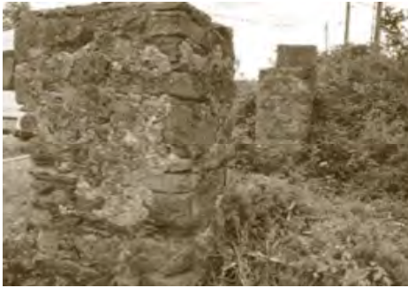
Imagens: Fotografia da área e estruturas
