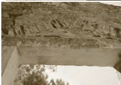
Imagens: Fotografias da área e estruturas
