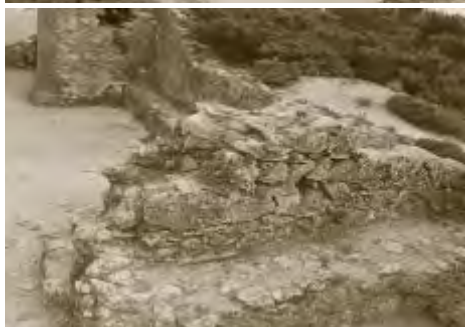
Imagens: Fotografia da área e estruturas
