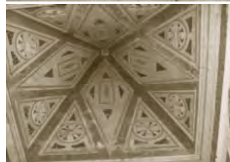
Imagens: Fotografia da área e estruturas
