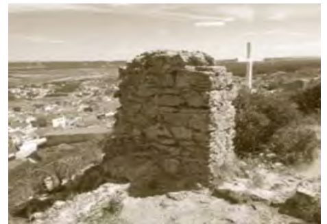
Imagens: Fotografia da área e estruturas
