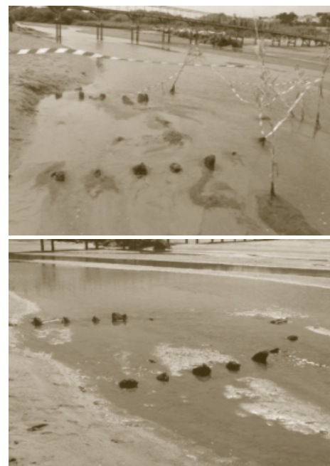
Imagens: Fotografias da estrutura aquando dos trabalhos da DGPC
