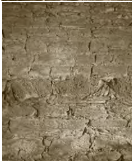
Imagens: Fotografia da área e estruturas
