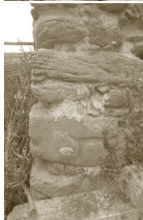
Imagens: Fotografias da área e estruturas
