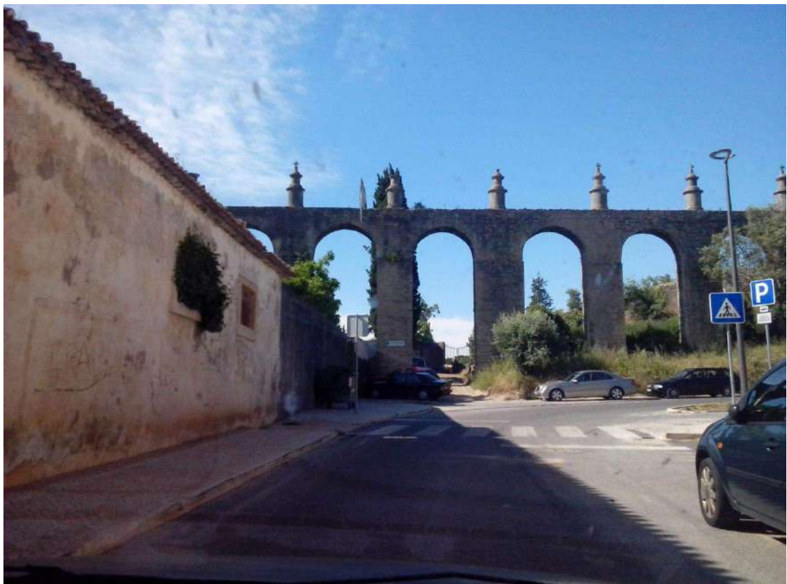
Figura 25 - Edificados e troço do Aqueduto
