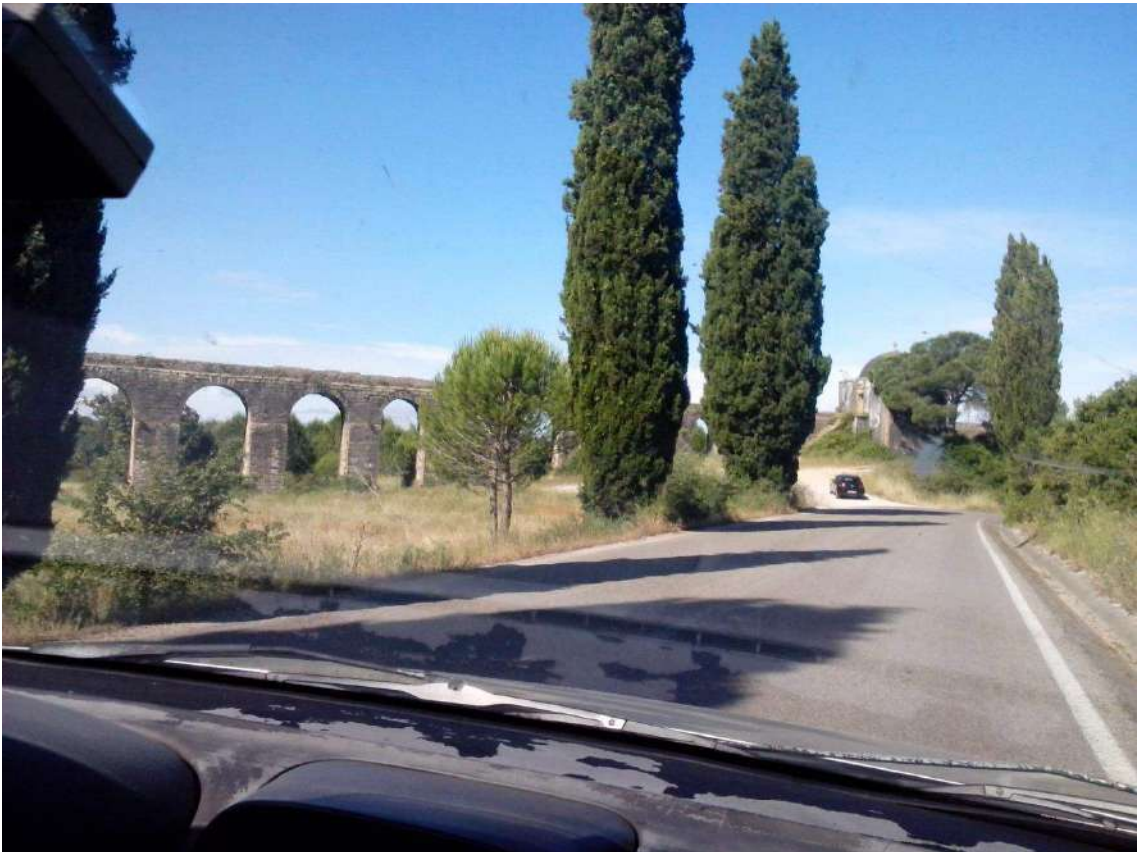
Figura 31 - Vista do aqueduto e Casa da Água do lado do Convento de Cristo
