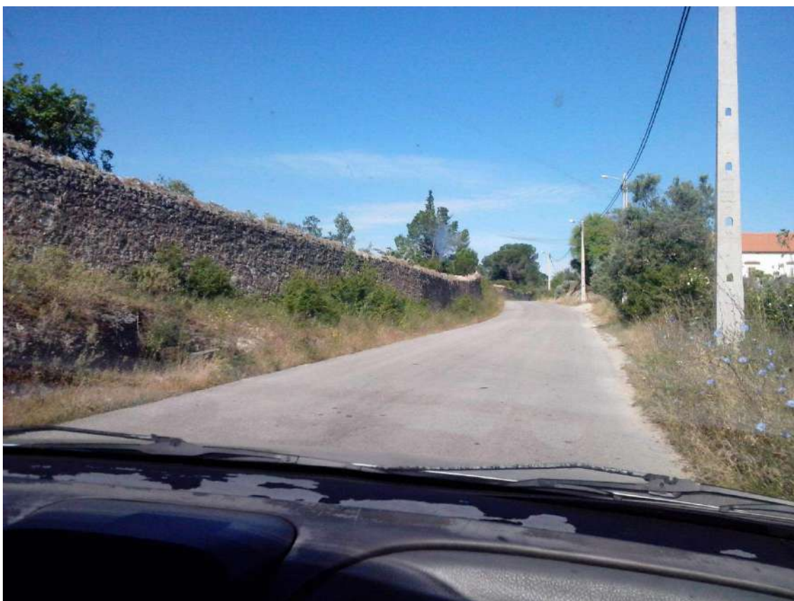
Figura 27 - Vista do muro que delimita a Mata
