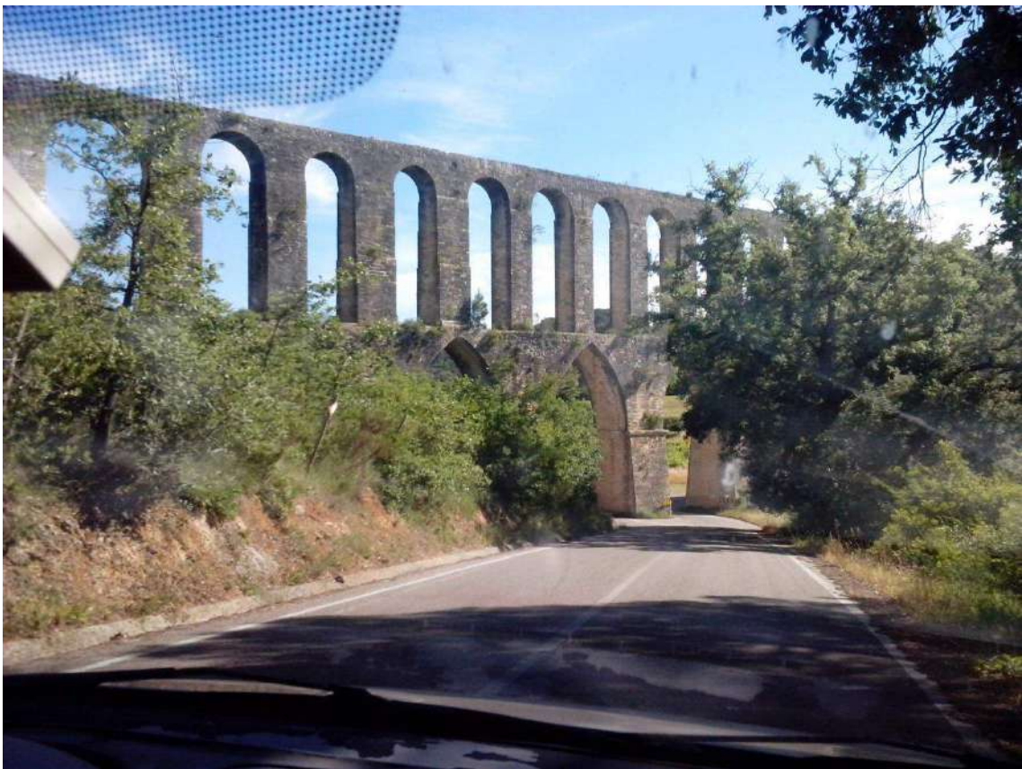
Figura 37 – Pormenor da arcaria no sentido Brasões - Tomar
